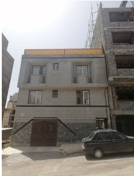
ساختمان همسایه شرقی
